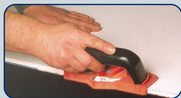
Обработка ГКЛ кромочным рубанком
